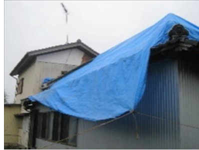
風で飛ばされたブルーシートの掛け直し
