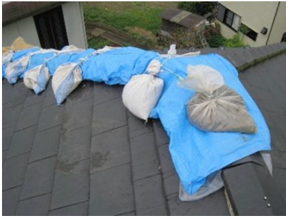
棟のシートがずれており、再度点検し掛けなおし作業終了
