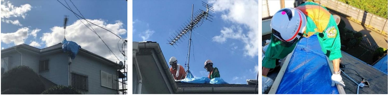
棟の破損：ブルーシートを除去し、棟トタンを仮止め新工法で補修修理
