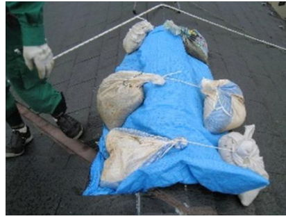
棟のシートがずれており、再度点検し掛けなおし作業終了
