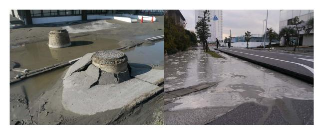
平成23年東北地方太平洋沖地震での浦安市での液状化
